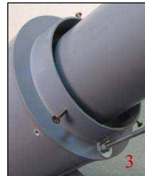
3. نثبت قسطل ال 3 أنش بالتحويلة وبدورها نثبتها بقسطل ال 6 أنش .
